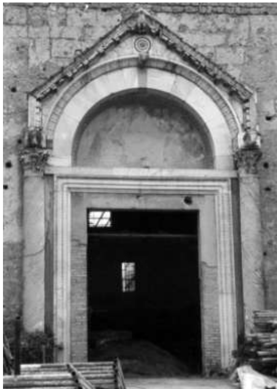
Il portale della chiesa abbaziale di San Lorenzo di Aversa, in corso di restauro (1990).
